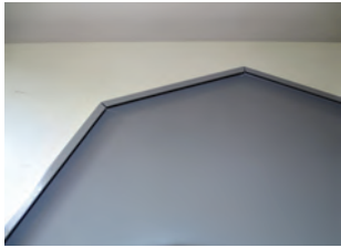
Obr. 6: Detail dvojitého ohybu okraje štítu
